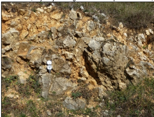
Slika 12. Rasjed – rasjedna zona „1“ otkrivena na usjeku iznad izvorišta Bašinač
